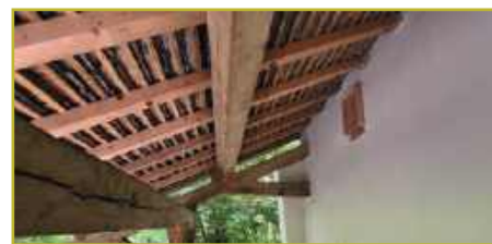
Abri à chauve-souris au lavoir de la Perche
